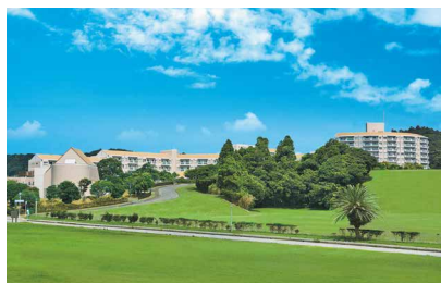
ラビドール御宿様 (千葉県) 介護居室 40 戸，一般居室 204 戸
